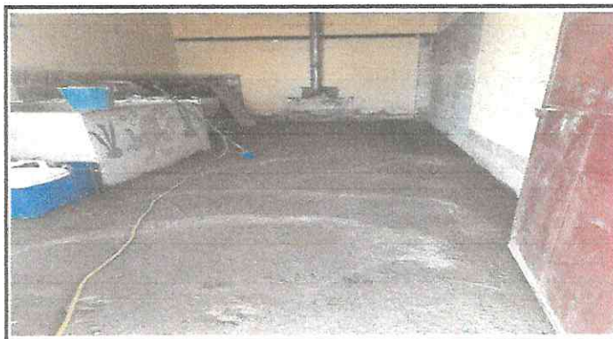
Sustitución de estufa rural completa, reparación de losa. Suministro e instalación de piso.
