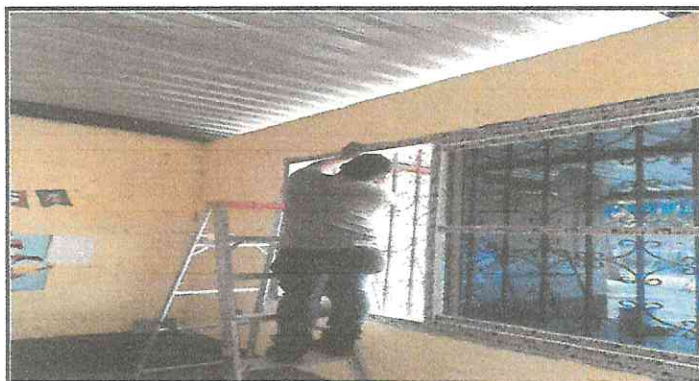
Suministro e instalación de ventana PVC de 2 divisiones.
