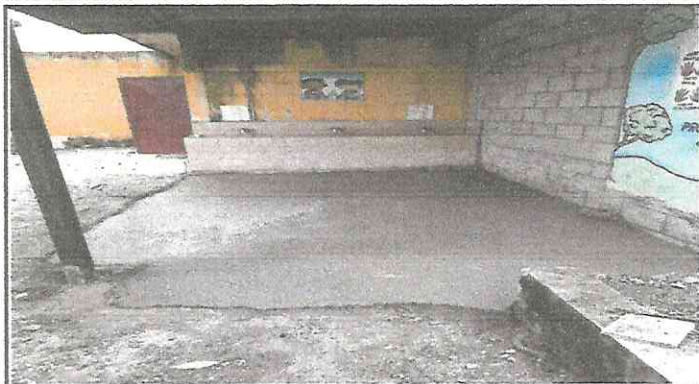
Reparación de losa de patio e instalación de accesorios de luz, tomacorriente, focos y apagadores.
