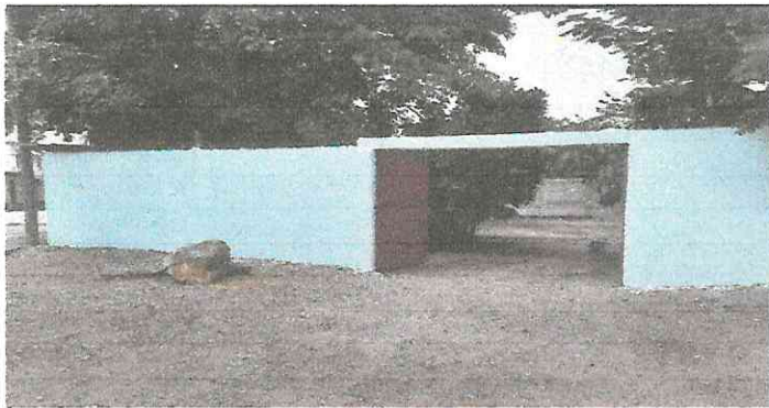
Repello en muro exterior y aplicación de pintura.
