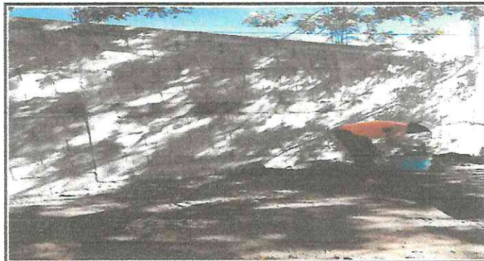
Reparación de muro perimetral.
